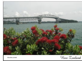
Harbour Bridge C.PC.AKL.08
