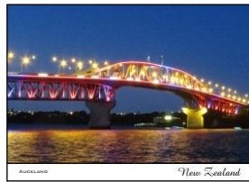
Harbour Bridge C.PC.AKL.55
